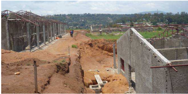
Vue générale du chantier
