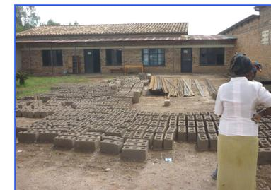
On fabrique les blocs de béton sur place par mesure d'économie
